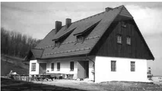
Im Herbst wurde die Fassade des Schöpflschutzhauses nach nunmehr 11 Jahren Bestand saniert. Der Verputz war an mehreren Stellen zum Teil stark beschädigt und an der Ostseite des Kellers waren Kabel außerhalb des Mauerwerks geführt.
